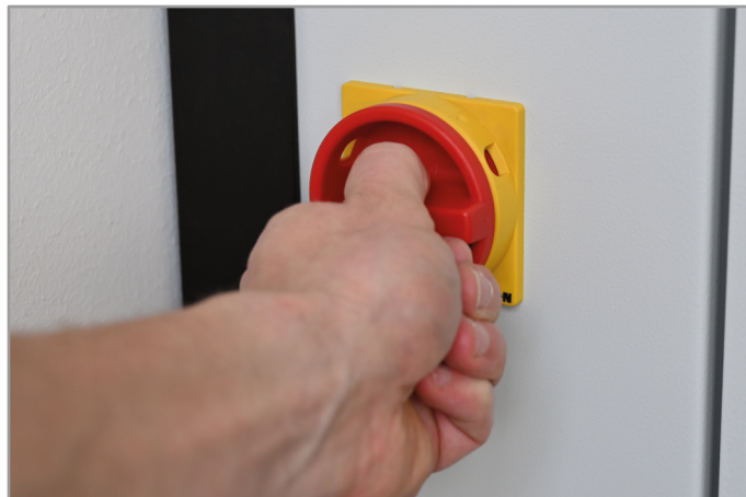
Schaltvorgang an einer Maschine Switching operation on a machine
