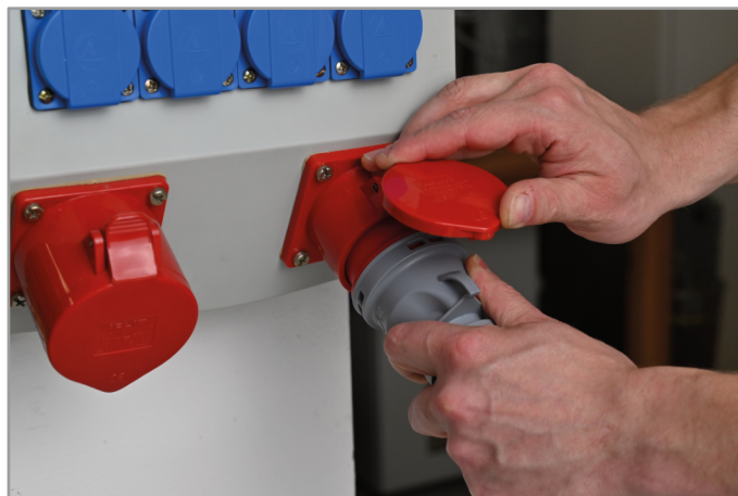
Kontaktierung eines CEE-Steckers Contacting of a CEE plug
